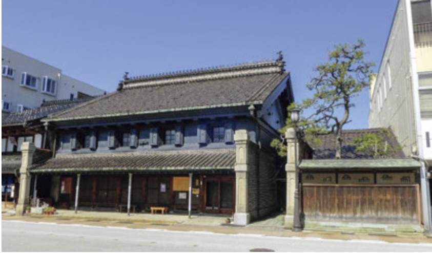
◀菅野家住宅(国重要文化財) 明治35年の堂々とした土蔵造り町家
