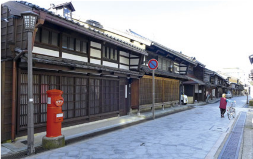
金屋町の町並み 格子・袖壁を備えた木造の町家が連なり美しい
